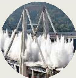
► L'esplosione dei resti del ponte Morandi a Genova
