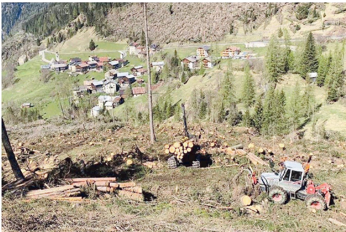
I primi lavori eseguiti nella zona di Livinalongo
